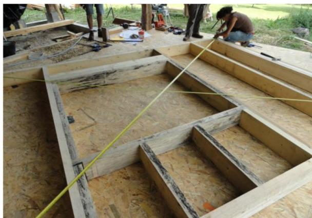
La technique d'équerrage avec les diagonales est très utile pour les panneaux de grandes dimensions, par exemple si vous faites débiter des panneaux de contreplaqué dans une grande surface de bricolage.
