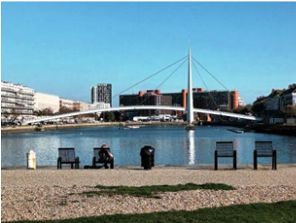
La passerelle François Le Chevalier et le bassin du commerce
