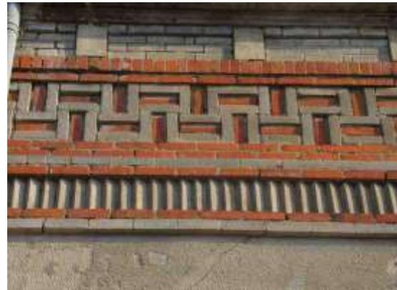
Les briques en terre cuite et en laitier de haut-fourneau forment des décors géométriques.
