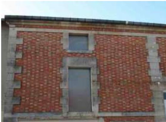
Dans ce mur, les alignements verticaux des briques laissent un peu à désirer.
