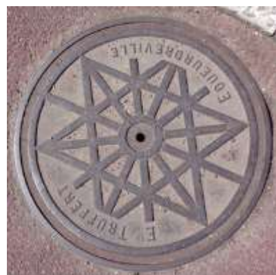
Sur une bouche d'égout à Villers sur Mer
