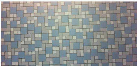
La pose du carrelage « COMBI » laisse cependant apparaître des lignes de fracture entre les lignes et les colonnes formées par les carreaux. Ceux-ci doivent être posés sur un sol bien stabilisé !
