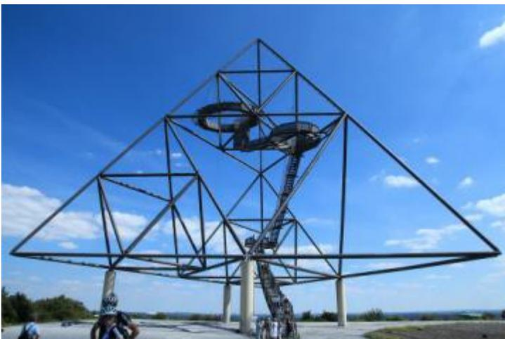
À Bottrop, ancienne cité houillère de la Ruhr, l'architecte Wolfgang Christ a réalisé une telle structure. Les trois plateformes culminent à 18 m, 32 m et 38 m. Ces renseignements ainsi que la taille des visiteurs au pied de l'escalier permettent de trouver une approximation des dimensions de l'œuvre.
