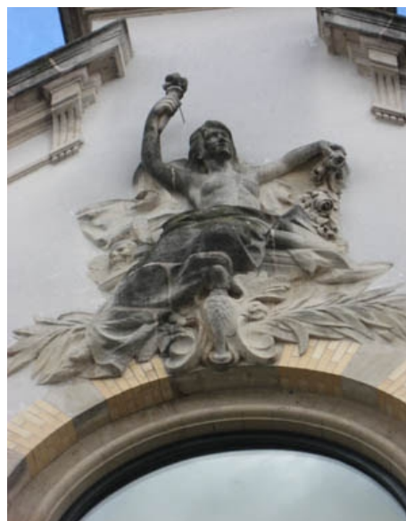
La façade de l'ancienne A.G. rue Gustave Simon
