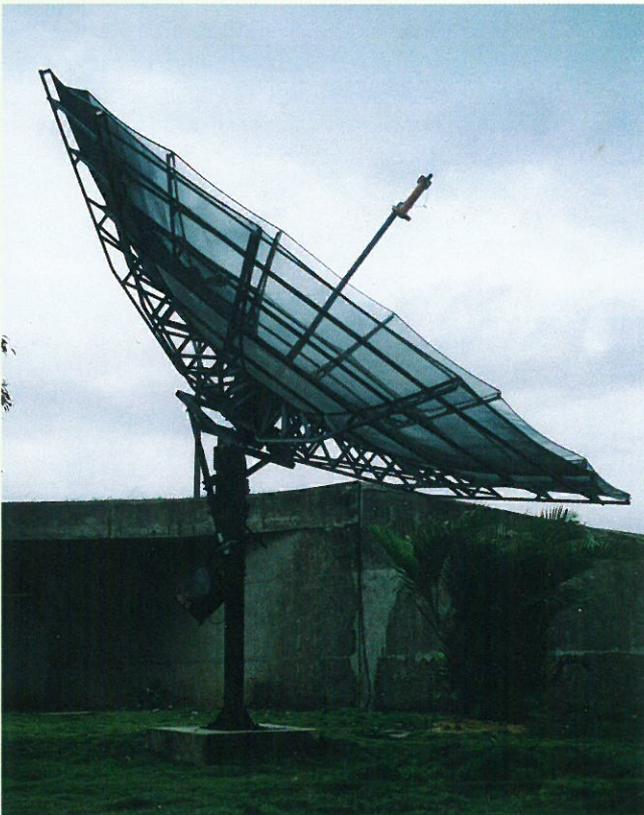
**Une parabole de réception satellite. Tous les rayons reçus sur le grillage dans l'axe de la parabole sont concentrés à l'extrémité de la tige centrale : c'est là que le récepteur est placé**
