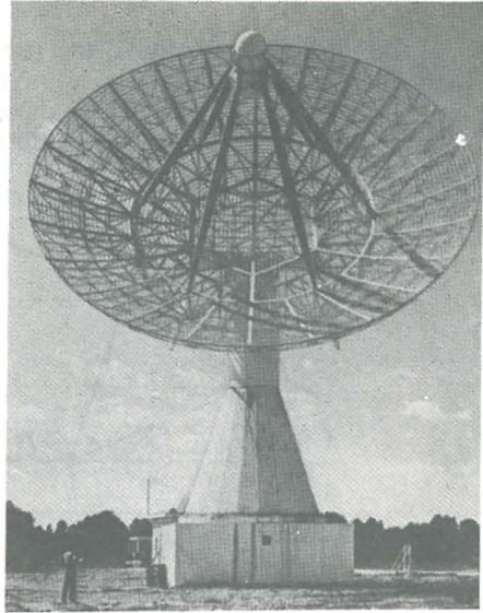
*Le Japon veut "prévoir" l'arrivée d'un typhon, avertir les populations et prendre toutes mesures utiles. Cet énorme radar, installé au sommet de l'observatoire de Muruto, tourne vingt-quatre heures sur vingt-quatre et peut détecter un typhon à plus de 400 kilomètres de distance. (Photo Agip).*
