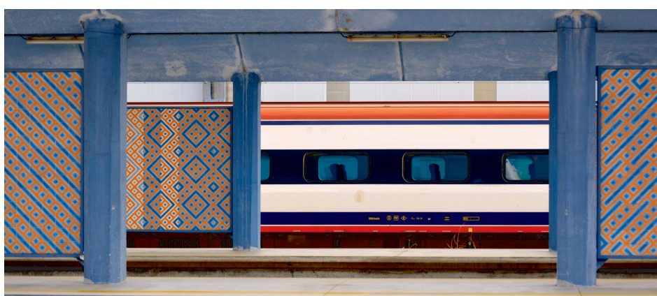
Figures 2 et 3. Gare de Contumil (Porto, Portugal). Crédit photo : Fernando Sousa Lopes.
