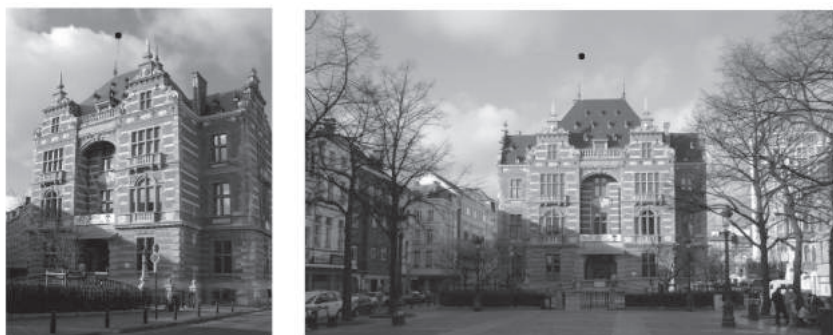
Figure 1 : L'Institut Cooremans et la place Anneessens
